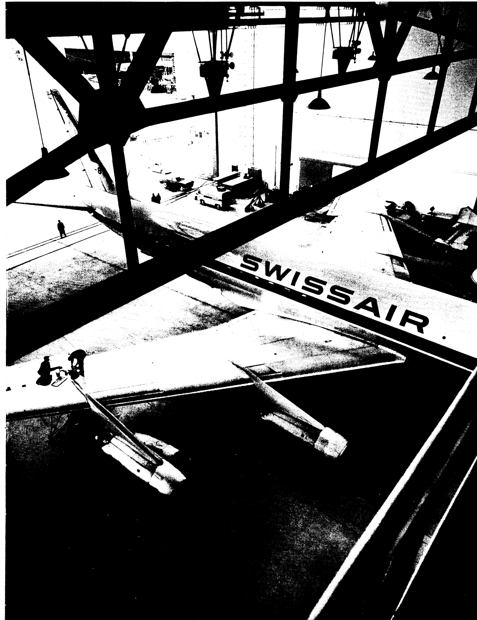
Neue Werfthalle in Kloten für grosse Strahlflugzeuge
